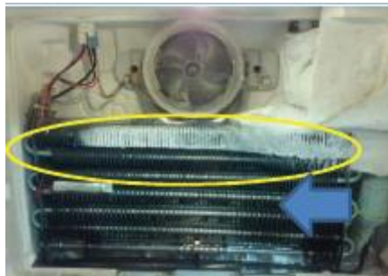
علامت کمبود گاز: یخ زدگی در قسمت بالایی اواپراتور رخ می دهد و هیچگونه هوای سردی در قسمت پایین اواپراتور وجود ندارد.
